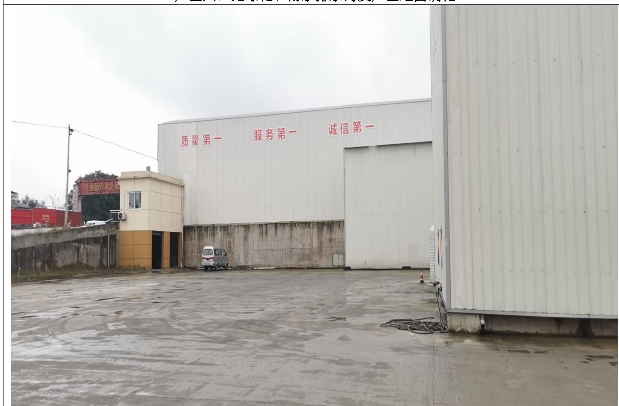
厂区地面硬化
