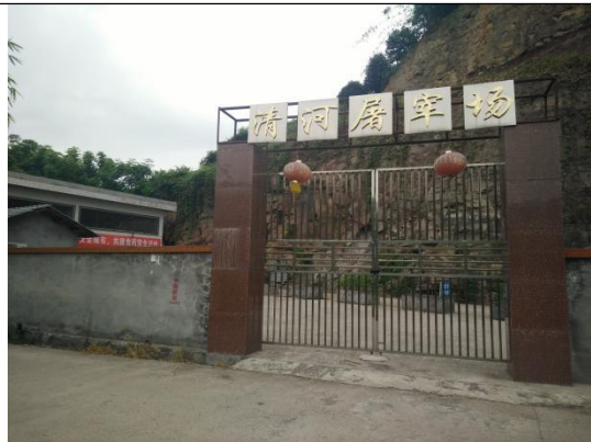
项目厂区大门
