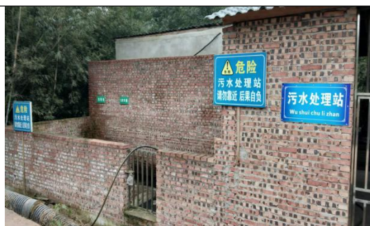
项目污水处理站
